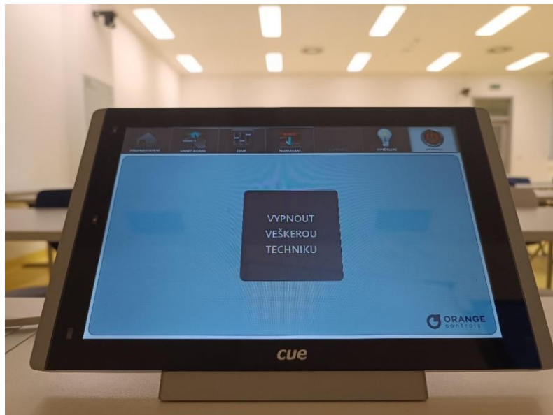
Obr. 12: Vypnutí techniky při odchodu
